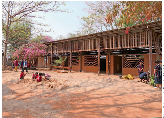
Das Gebäude bietet Platz für vier Klassenräume, die vorne durch eine überdachte Veranda miteinander verbunden sind.
